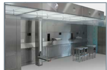
LAF Umluftkabine mit Einwaage und Probenzug
